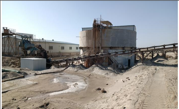
尾矿压滤车间
