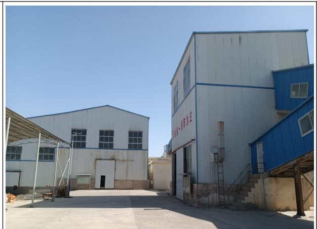
设备安装在车间内
