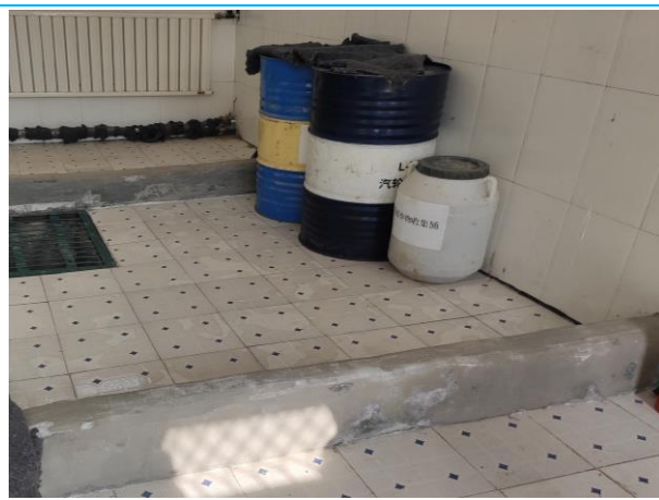
危废暂内部结构
