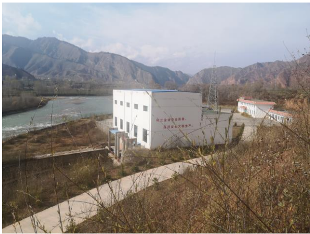
发电厂房及办公区绿化情况
