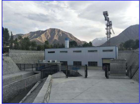
水电站发电厂房外景
